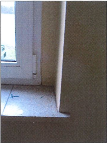
OKNO WIDOCZNA: OŚCIEŻNICA OŚCIEŻA PARAPET PŁYTKI LASTRICO
